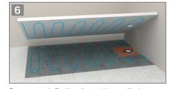
Para asegurar la fijación aplicar tambien masilla de poliuretano sobre la parte inferior del plato de ducha y colocar sobre la superficie haciendo coincidir el hueco calado de desague sobre la válvula.
