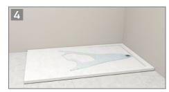
Para comprobar que la superficie esta totalmente nivelada y que la válvula no queda por encima de la misma colocar el plato de ducha sobre la superficie y comprobar que desagua correctamente.
